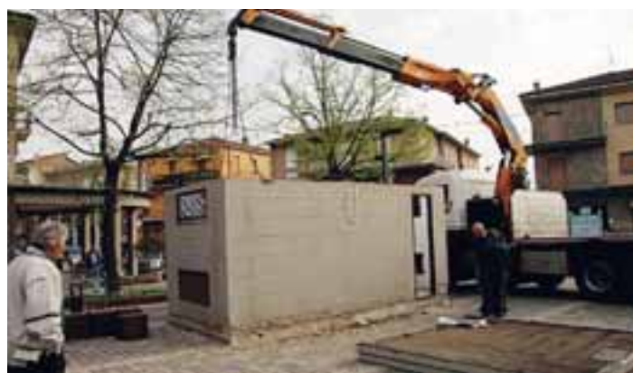
SAN GIORGIO - La rimozione della "casetta" che avrebbe dovuto ospitare un trasformatore mai arrivato (foto Marina)
